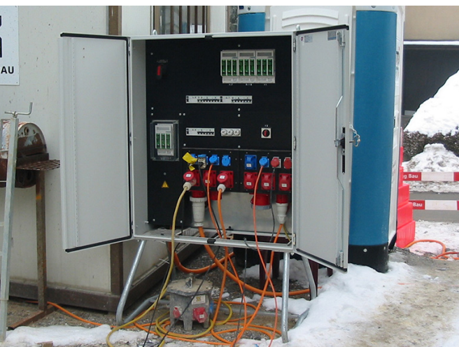
Distributore principale in cantiere
