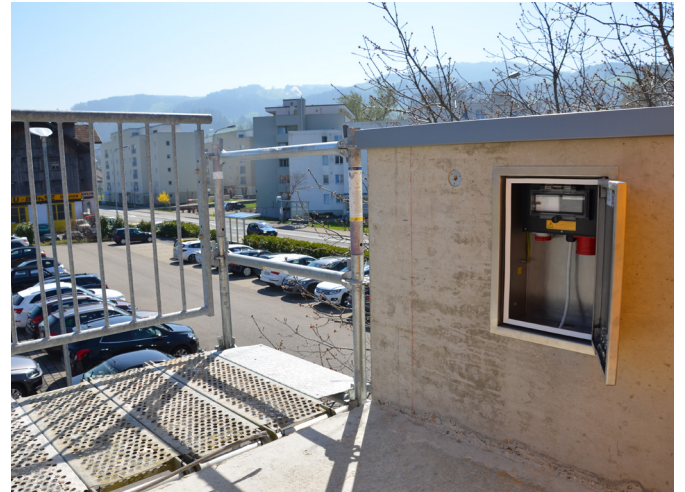
Distributore sotto muro incassato non ingombrante
